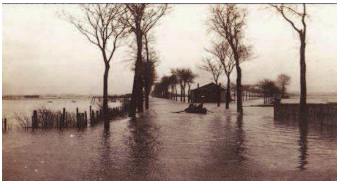
Fig. 17: Crue de la Seine de 1910 : Avenue du pont Saint Denis à Gennevilliers (source : DRIEE IF, 2011)
